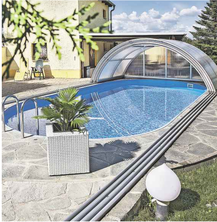
Badevergnügen im eigenen Garten: Schwimmbadbau Glocke setzt bei seinen Pools auf Qualität und Langlebigkeit. Fotos: Schwimmbadbau Glocke
